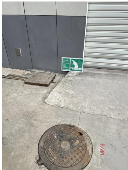
图 3-2 污水排放口环保标识牌
