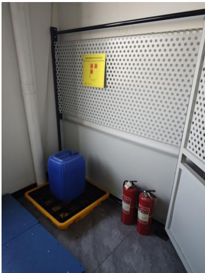
危废仓库落实分区标识牌和消防设施，地面落实硬化措施，产生的危废置于防渗漏托盘上。
